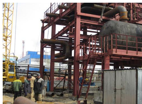
Рис. 3 Градирня ООО "Омсктехуглерод"
