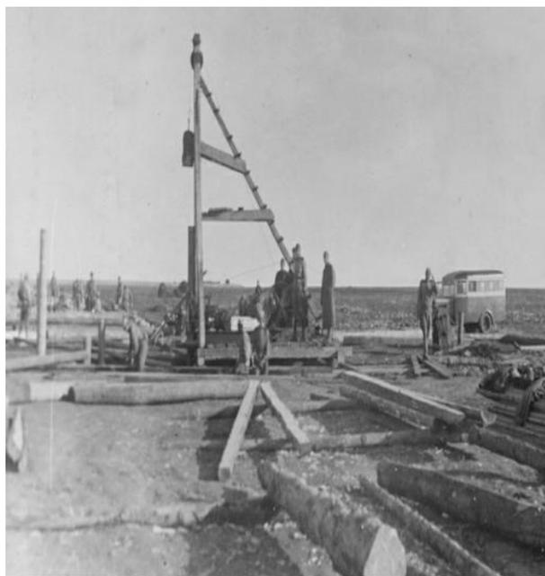
*Забивка свай на строительстве завода № 174 (АО «Омский завод транспортного машиностроения»). 1942 год*
